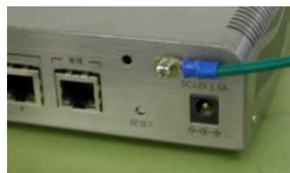
図 FGケーブル取り付け状態
